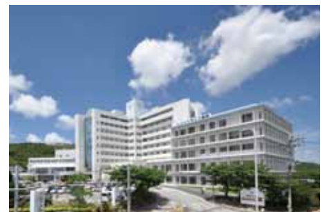
ハートライフ病院東館竣工
